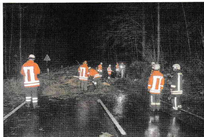
Freischneiden L 568 durch die Feuerwehr Bremke
